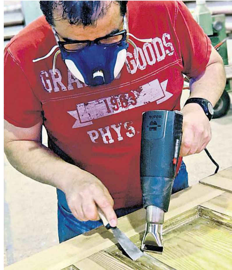
Hilfsarbeiten für Tischler werden erledigt.
